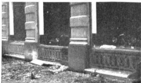
Explosión de una bomba en la agencia Ford de la calle Victoria y Perú.
